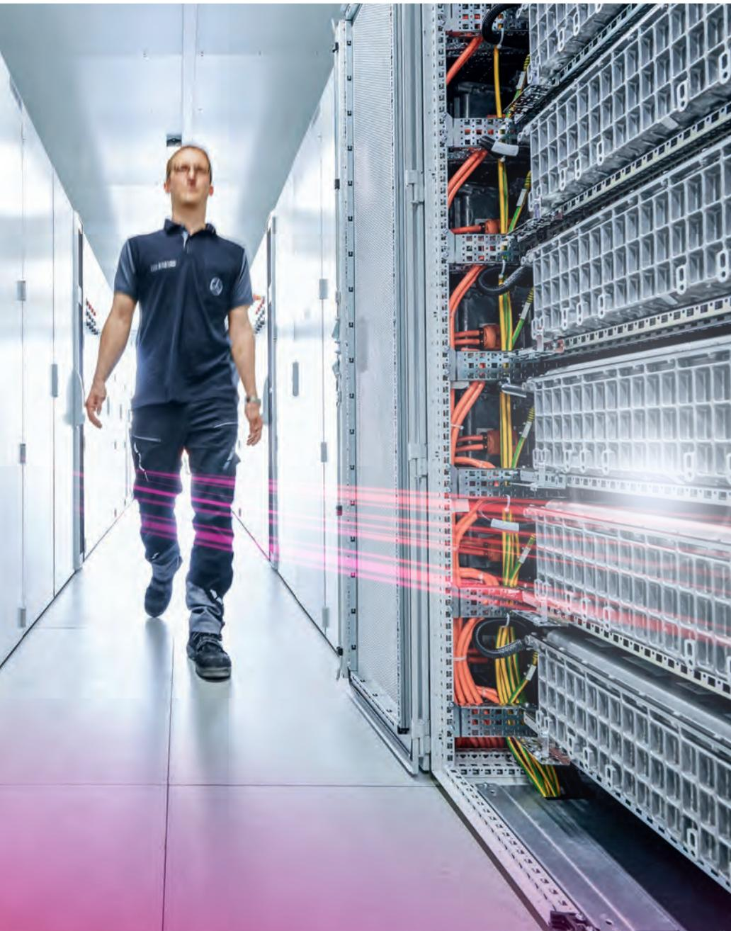
**Bausteine der neuen Energiearchitektur:** Fahrzeugbatterien, eingebaut in Schaltschränken als Energiespeichersystem powered by Mercedes-Benz Energy und Rittal.
